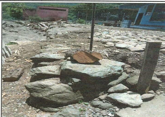
Foto 2: Muro de contencion en el area frente al corredor.
